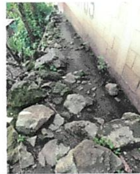
Foto 6: Reparacion de maya y losa de patio en callejon ✓
